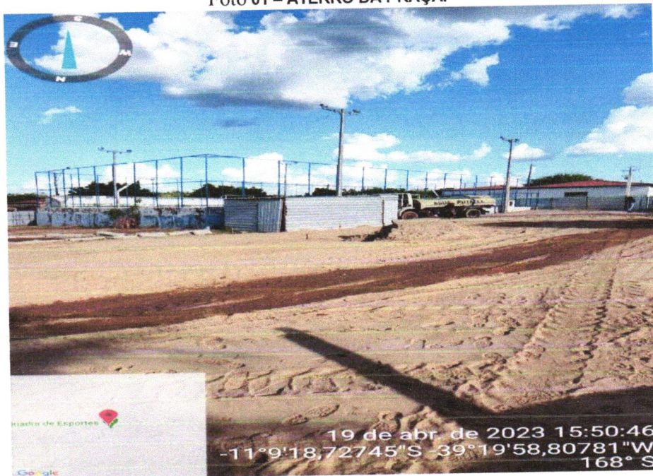
Foto 01 – ATERRO DA PRAÇA.
