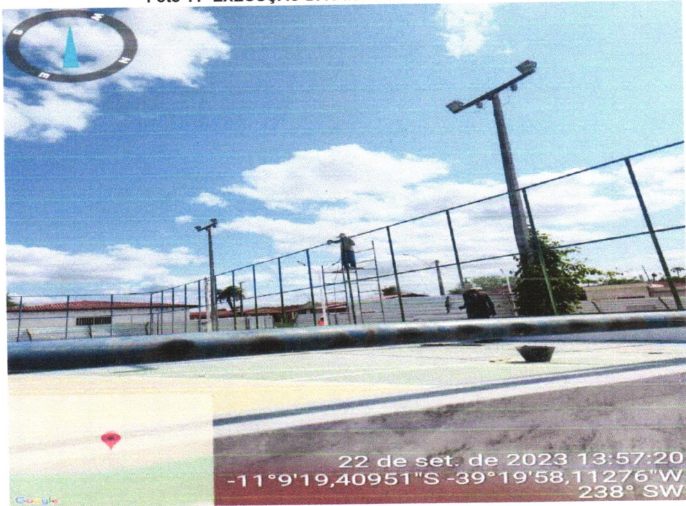
Foto 12- EXECUÇÃO DO ALAMBRADO
