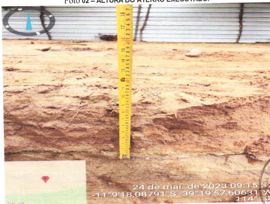
Foto 02 – ALTURA DO ATERRO EXECUTADO.
